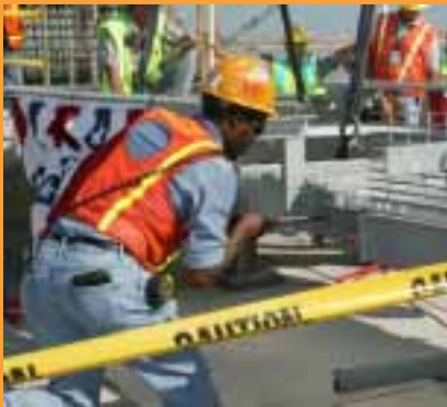
Trabajador instalando a nueva sección
