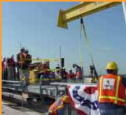
Estructura de metal para las guías
