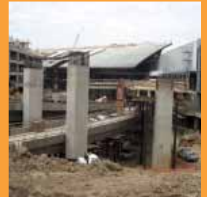
Caminos de la Terminal D
